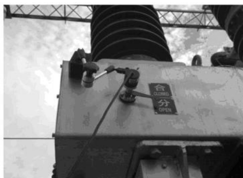
35KVSF6 开关传感器安装
