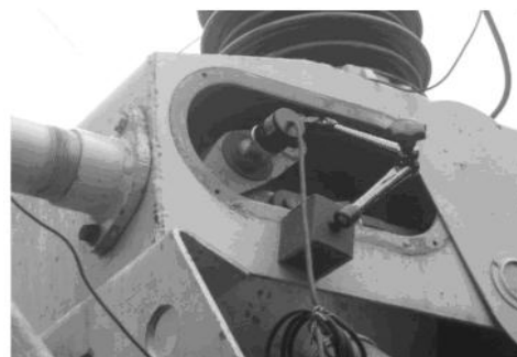
110KV SF6 开关传感器安装
